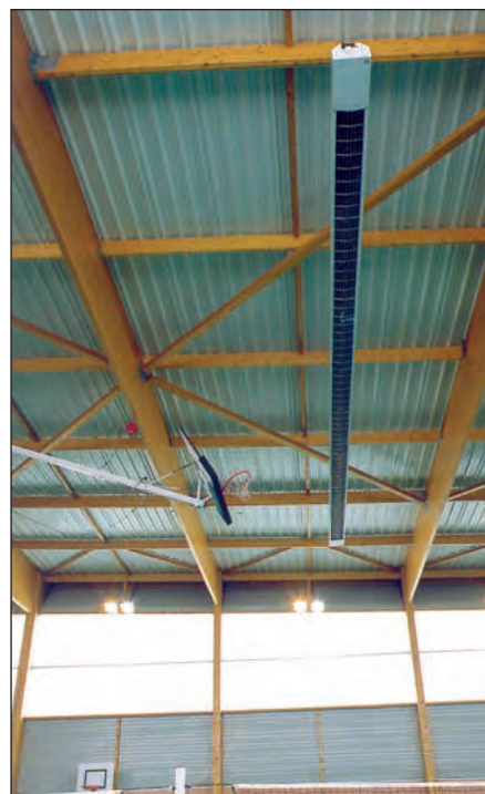
Eclairage latéral, chauffage zénithal
